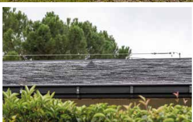
Nueva cubierta de pizarra del Chalet de Golf.
