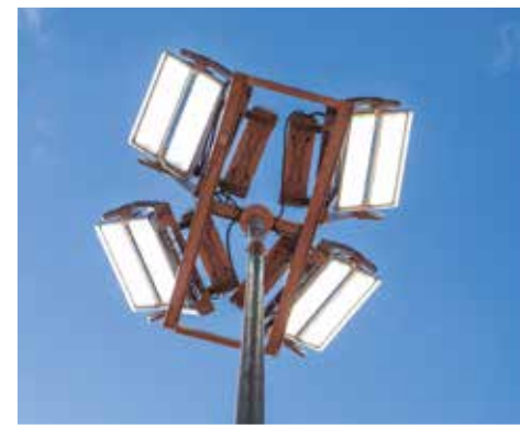
Cambio de la iluminación de las pistas 1 y 2 de tierra batida.
