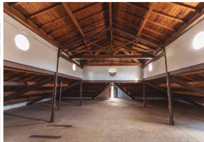
Rehabilitación de la cubierta del edificio de la cuadra nº 5.
